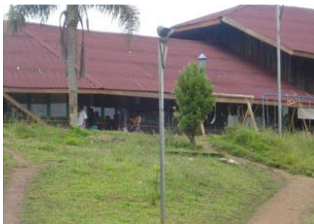
Pré-escola municipal na Aldeia Mbyá Tenondé Porã (São Paulo, Capital)
