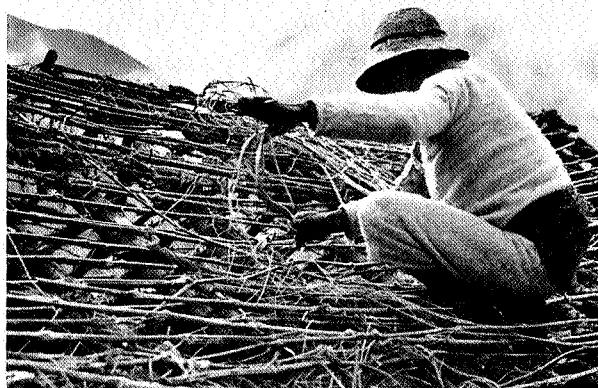
4. A Chia, réfection du toit d'une habitation. (photos de l'auteur)
