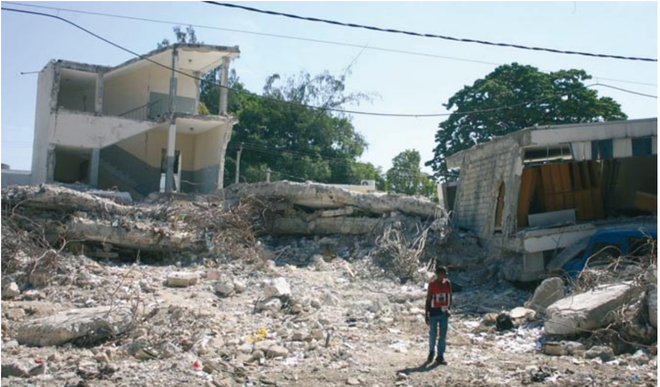
Edificio principal de la Escuela Nacional de Enfermería de Port-au-Prince (ENIP). Más de 100 muertos.
